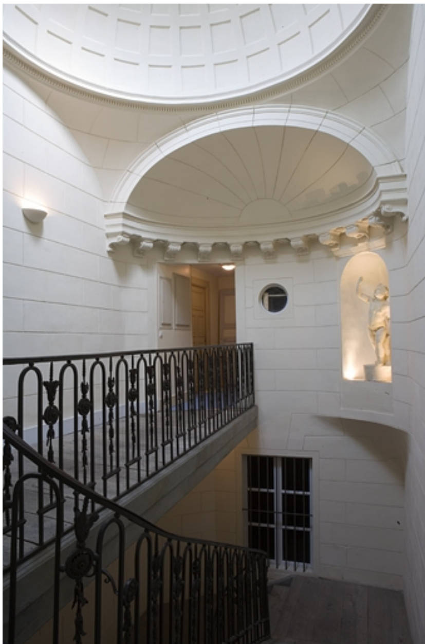
Escalier, dernier palier : détail de la demi-coupole.
