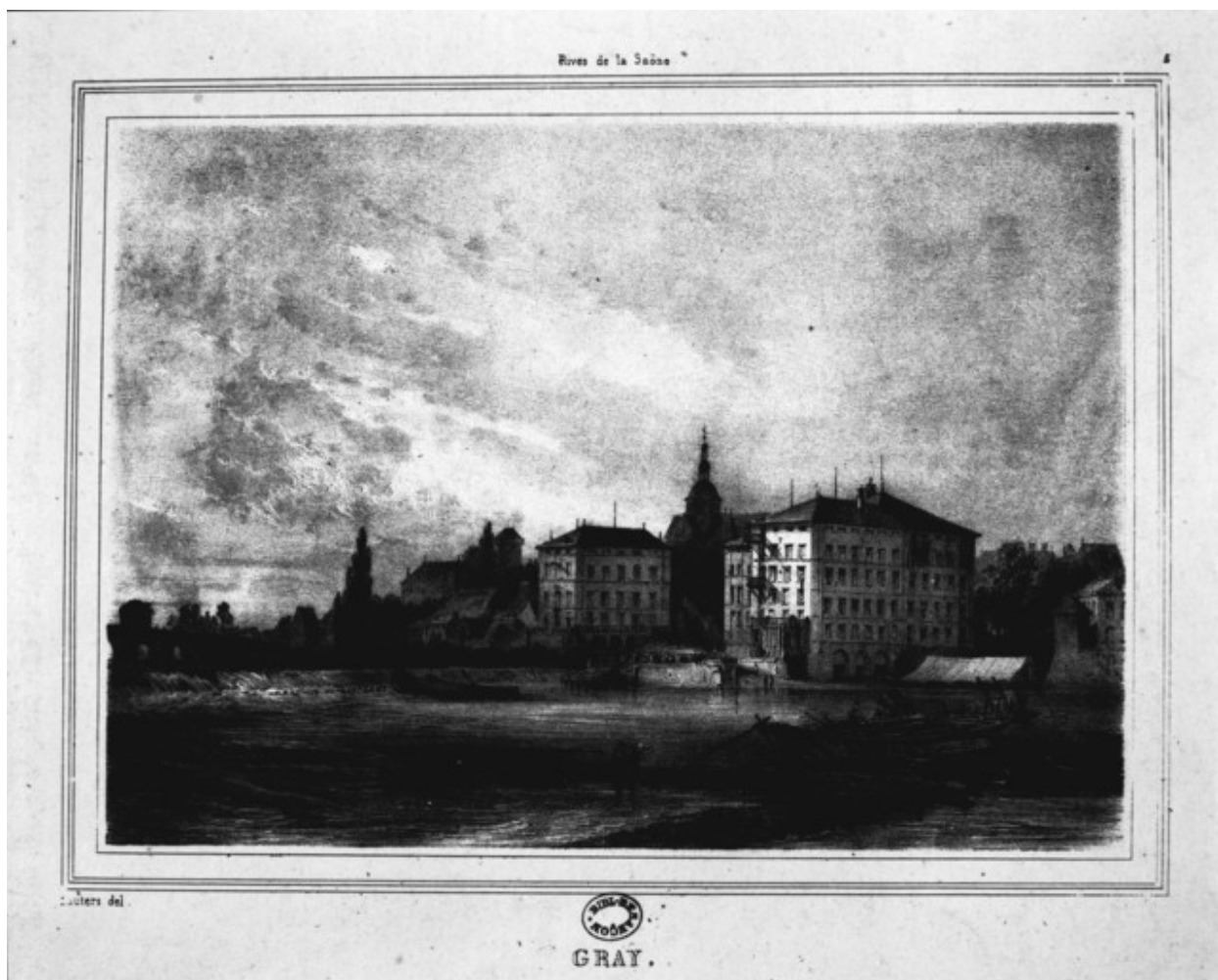
Rives de la Saône [vue d'ensemble depuis la rive droite].
