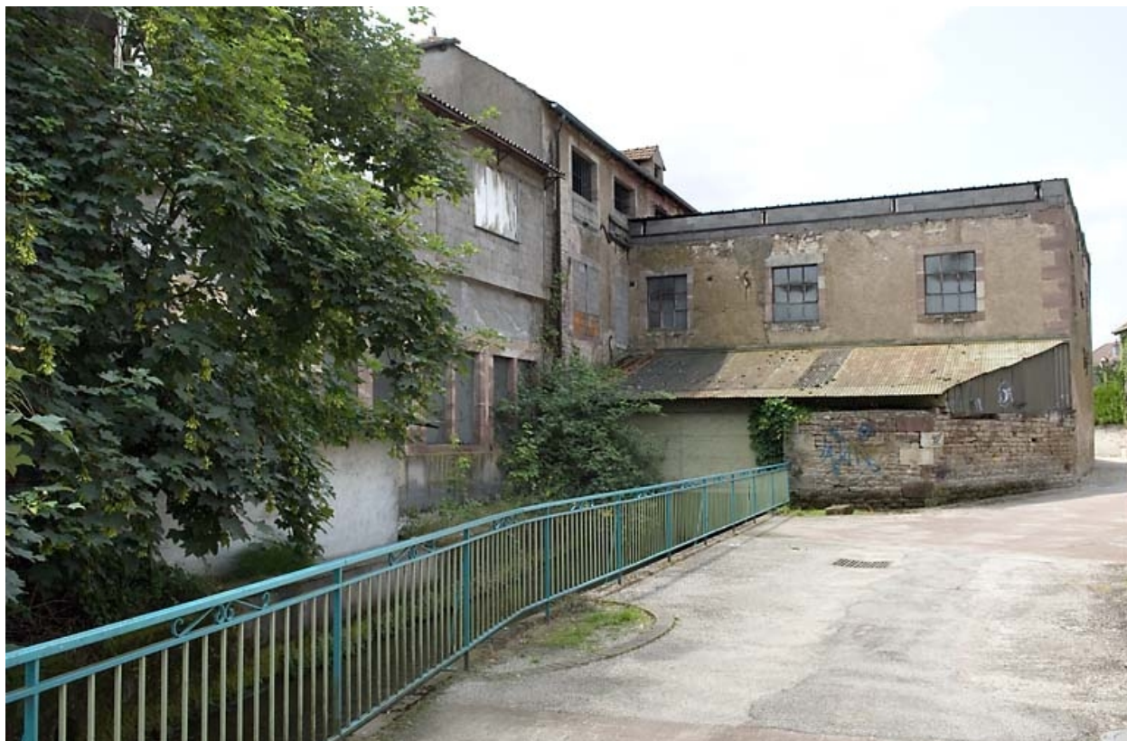
Façades postérieures donnant sur le bief.
