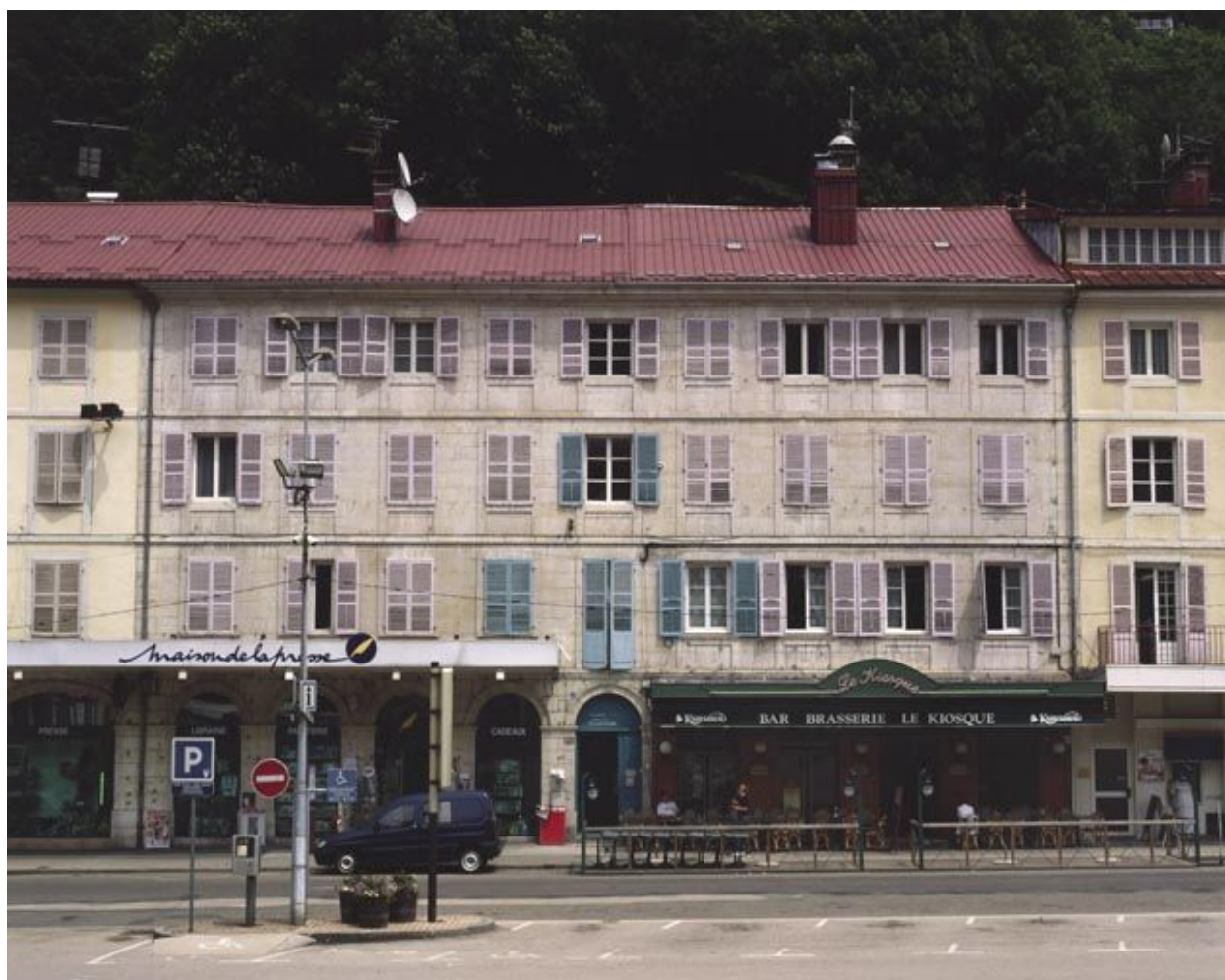
Vue d'ensemble des n° 131 et 133.
