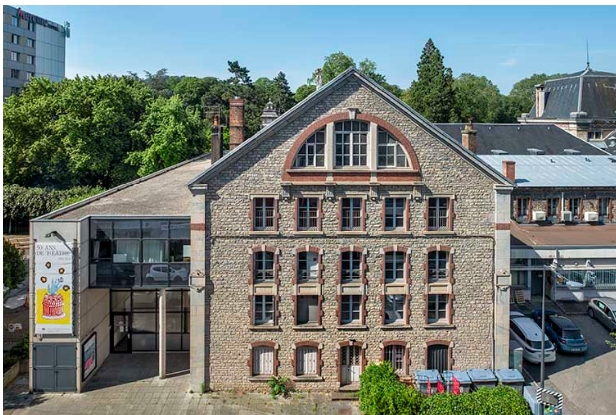
Façade sur la rue de la Mouillère.
