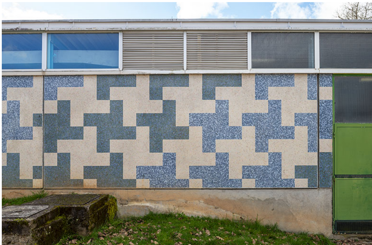
Détail de la façade nord-est.
