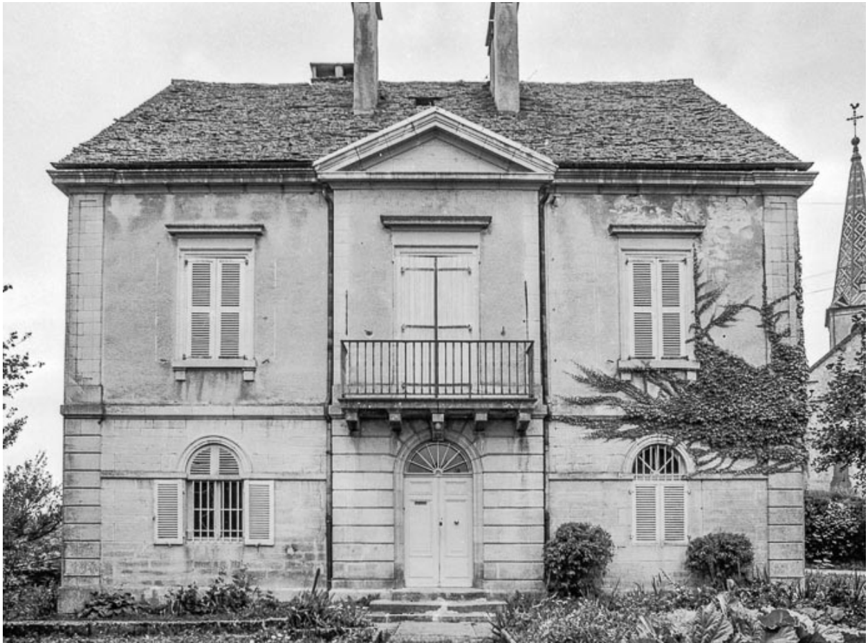
Façade antérieure vue rapprochée de face.
