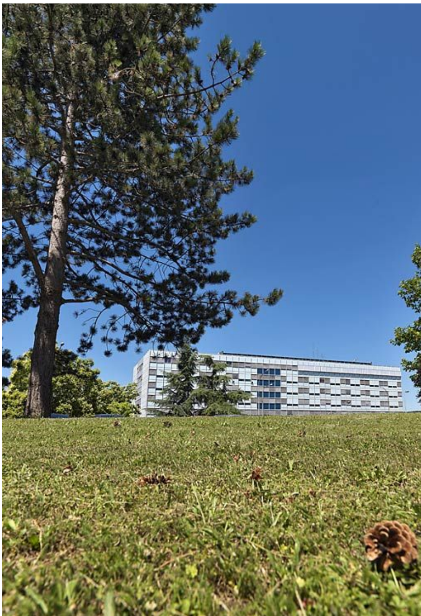
Bâtiment principal, vue d'ensemble.
