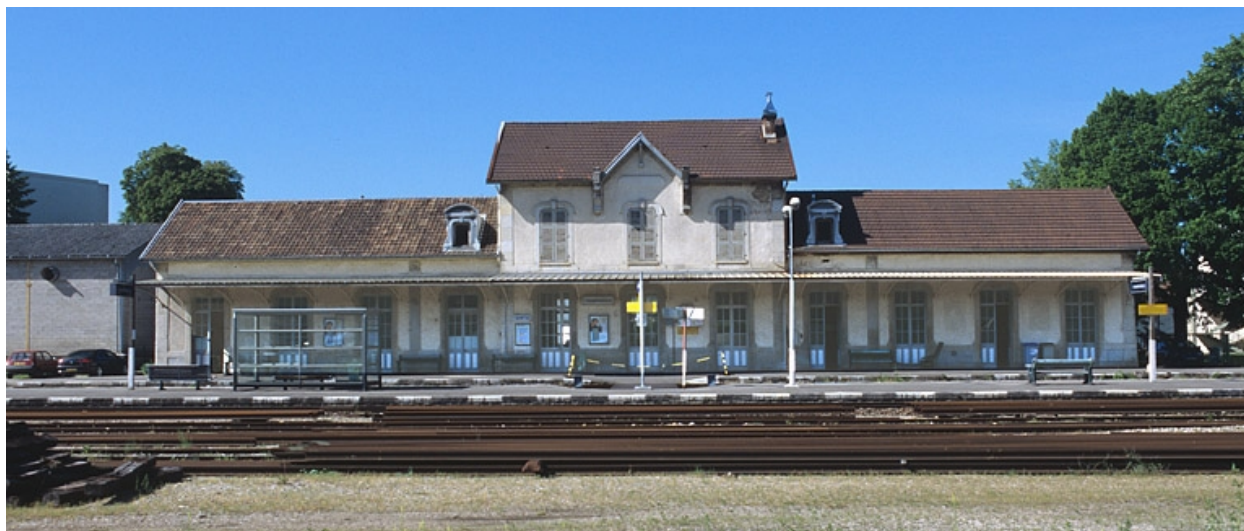
Bâtiment des voyageurs : façade postérieure.
