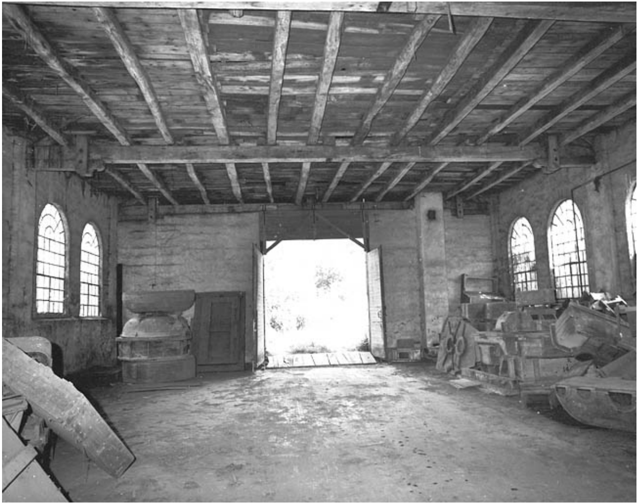
Partie sud de l'atelier de fabrication en 1981.
