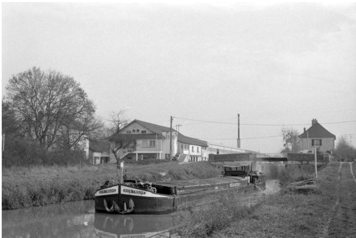
Vue d'ensemble depuis l'ouest, avec péniche.
