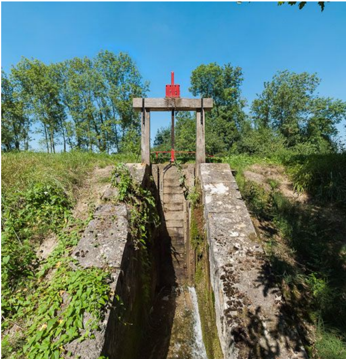
Rigole du déversoir sur le bief 78 du versant Yonne à Chassignelles, vue depuis le bas du talus.
