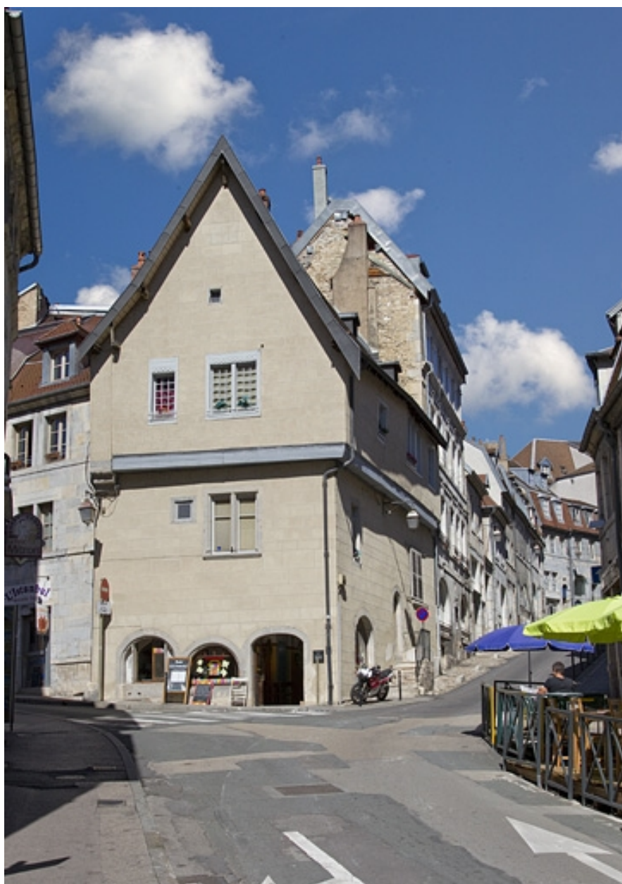
Maison : vue d'ensemble.
