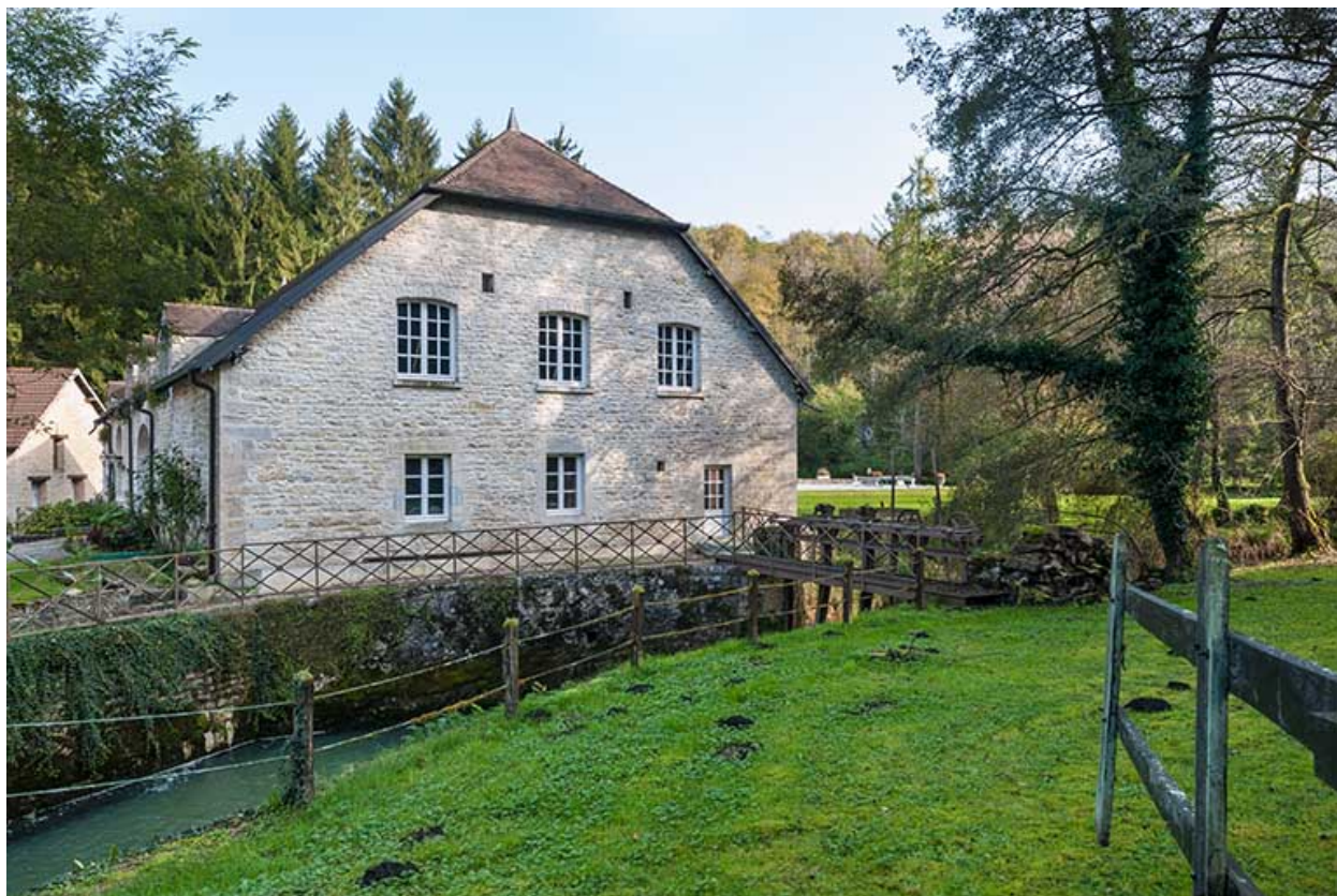
Pignon du moulin.
