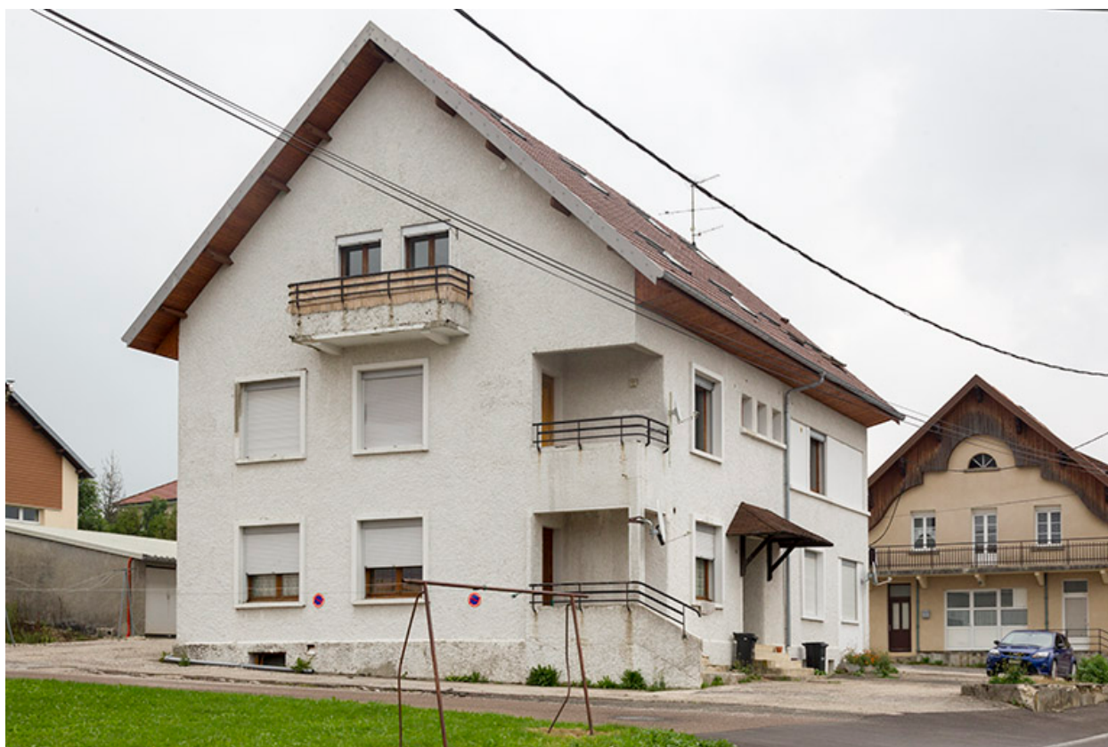
Façades latérale gauche et antérieure.
