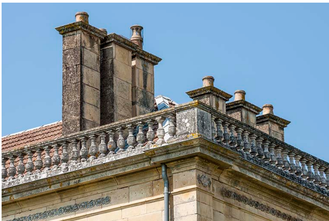
Balustrades et souches de cheminées.
