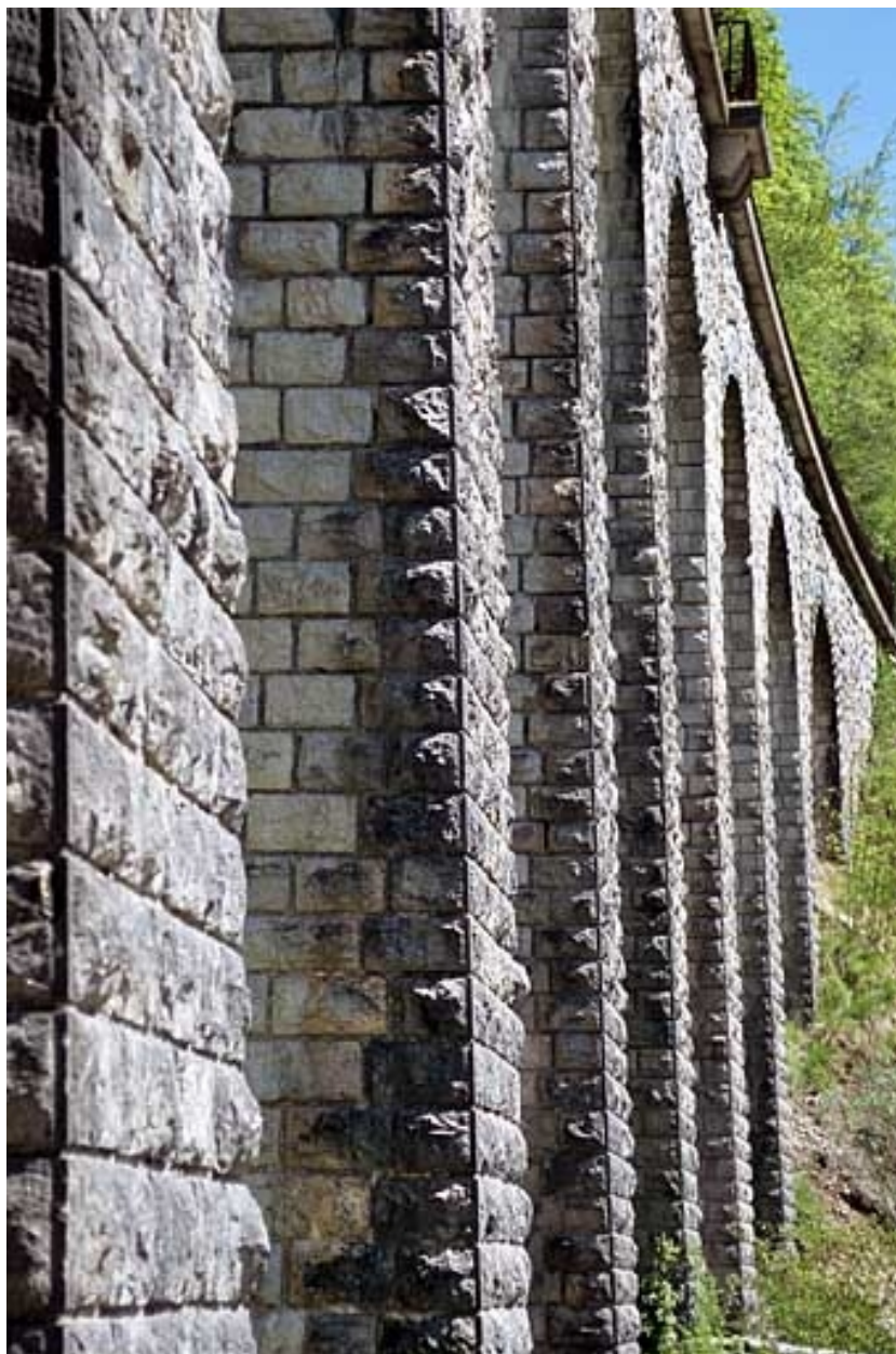
Viaduc du Puits : piles vues en enfilade.
