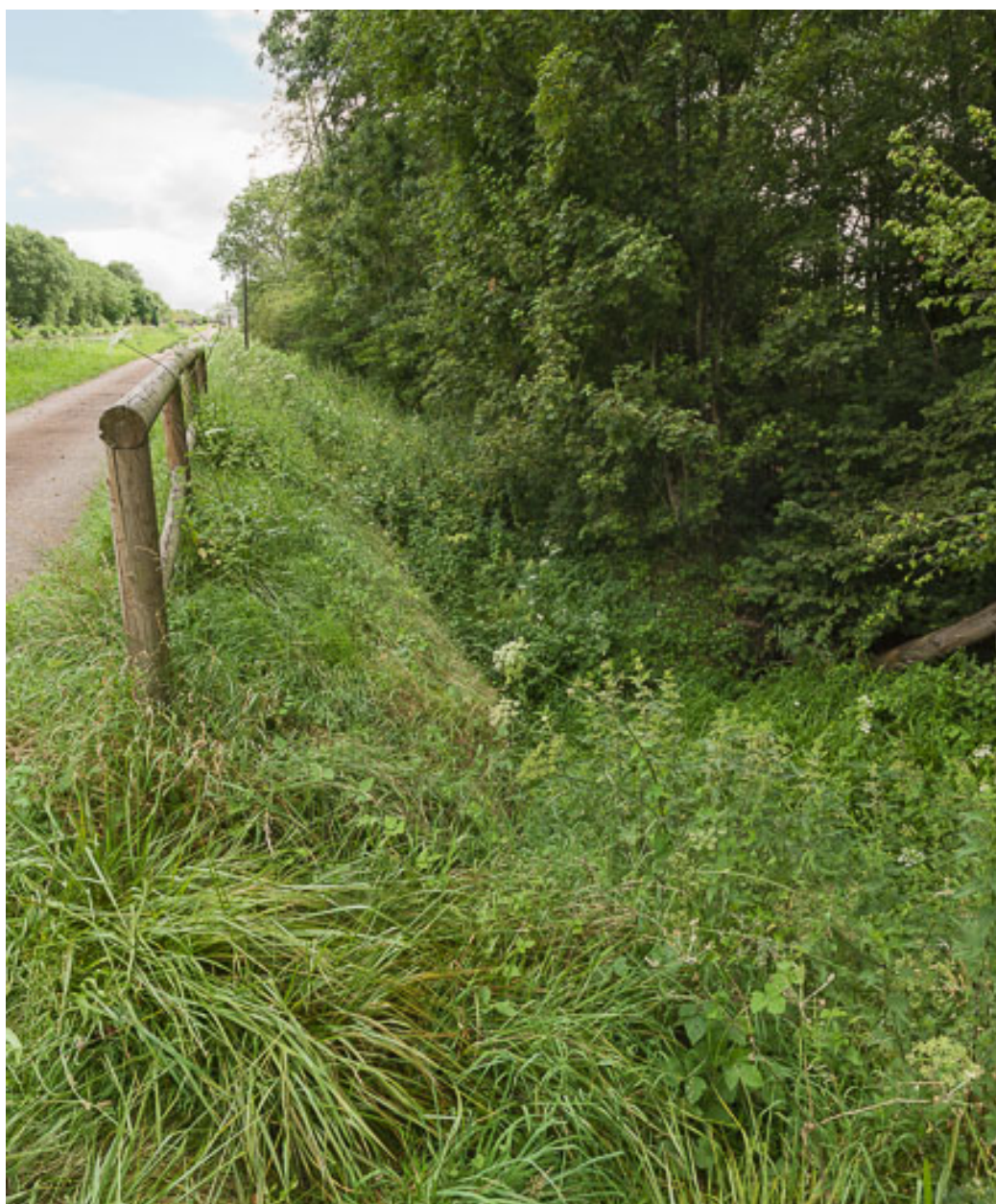
Vue de l'aqueduc.
