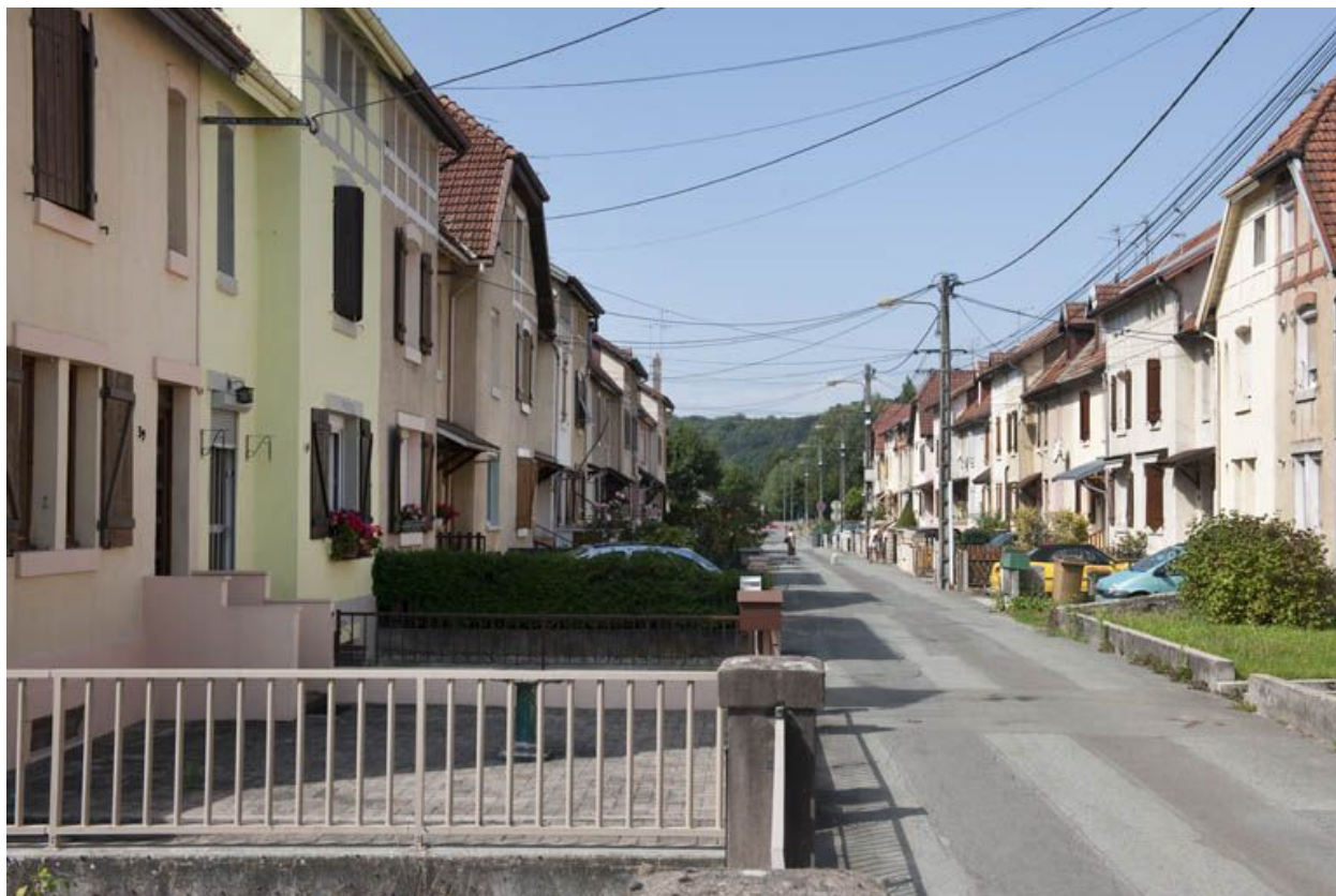
Rue de Somme. Vue d'ensemble.
