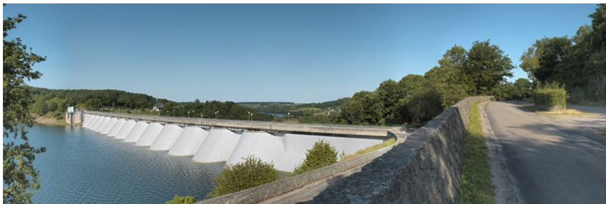
Vue générale du barrage.
