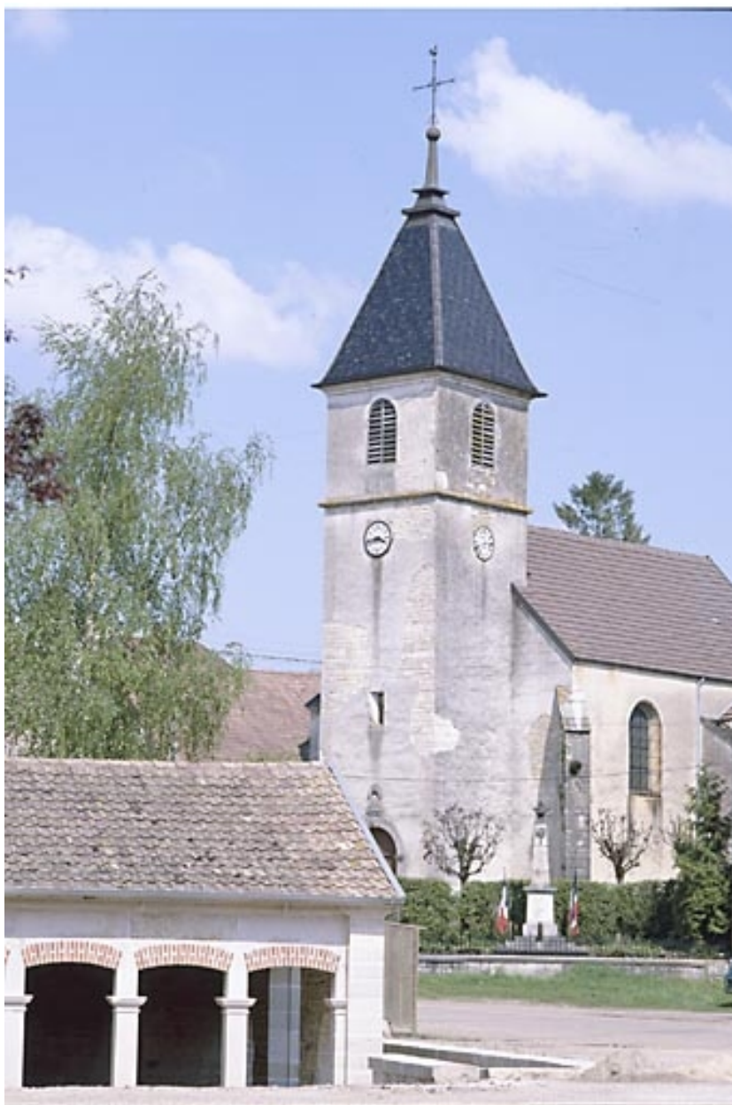
Façade antérieure dans le prolongement du lavoir.
