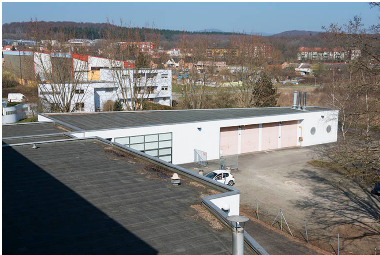
Façade sud des réserves.
