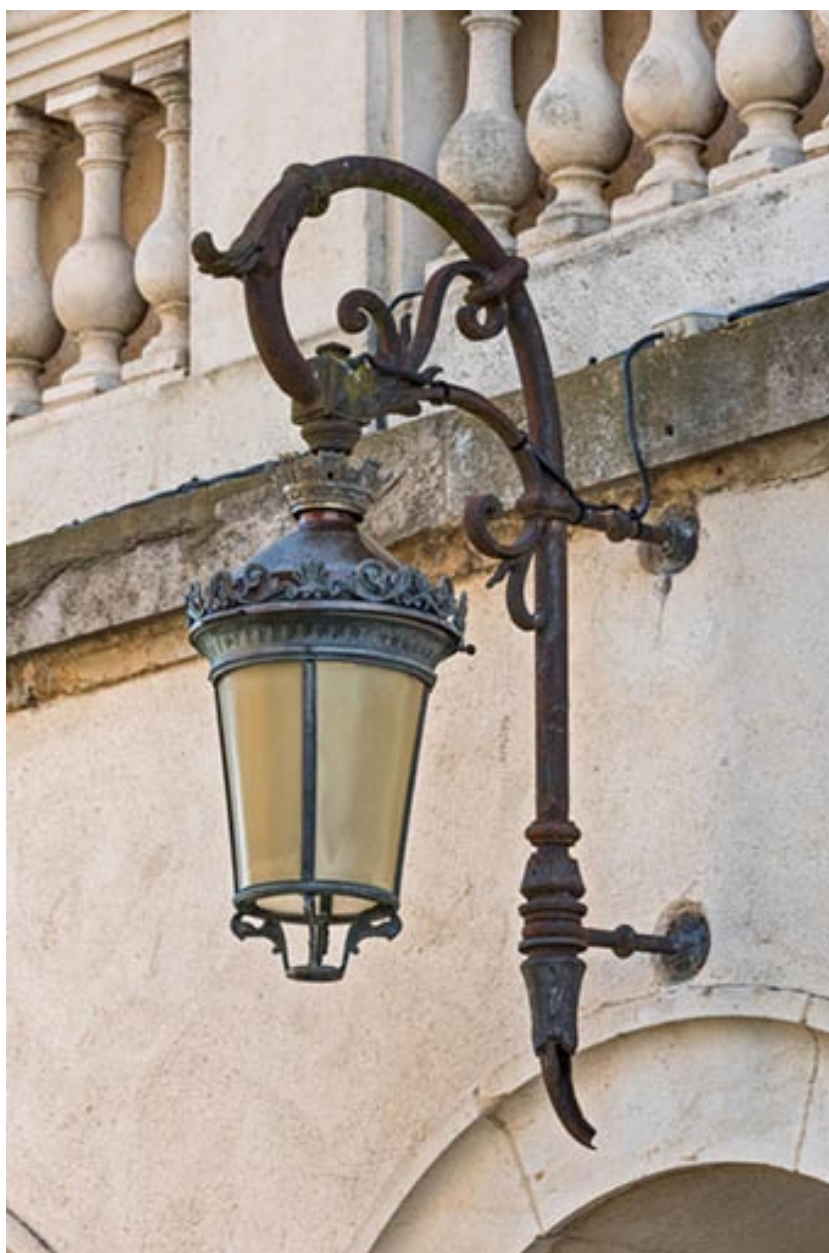
Façade antérieure : une lanterne.
