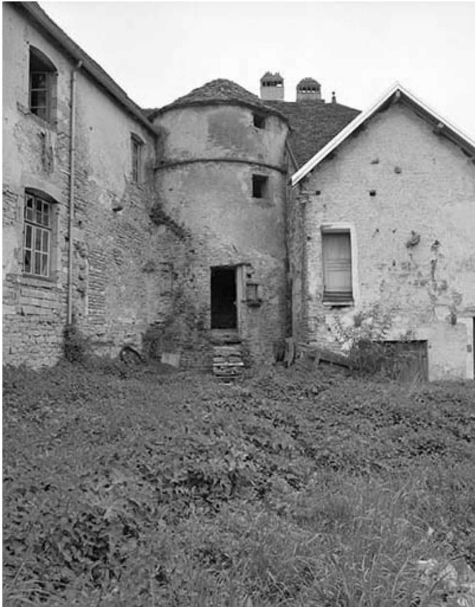
Façade ouest, partie gauche.
