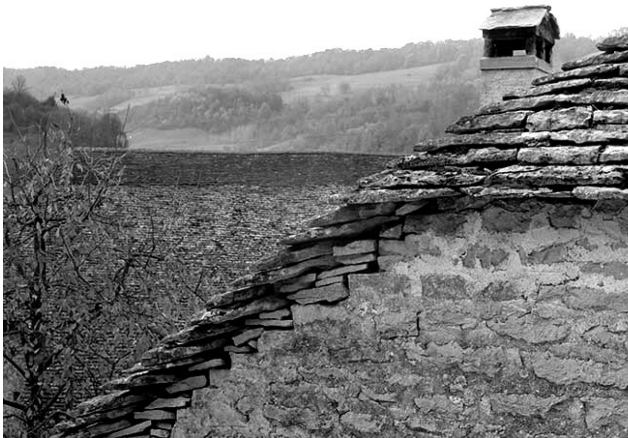
Détail d'une bordure de toit en laves.
