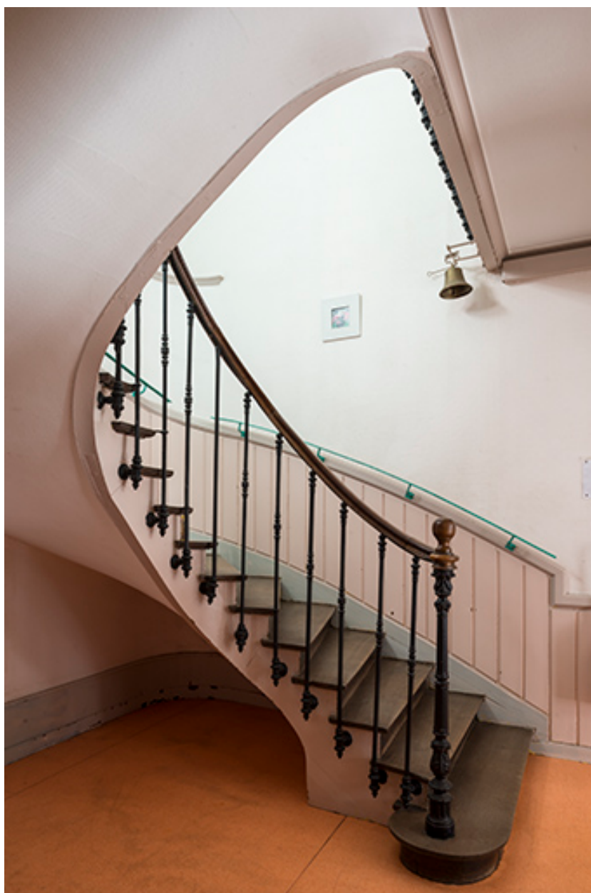
Escalier de type suspendu.
