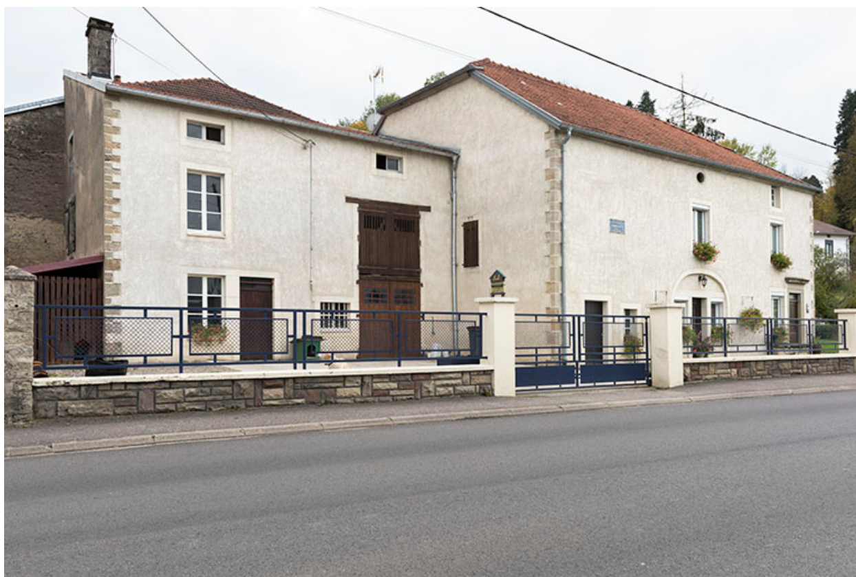
Maison 35, grande rue, vue de trois-quart nord-est.
