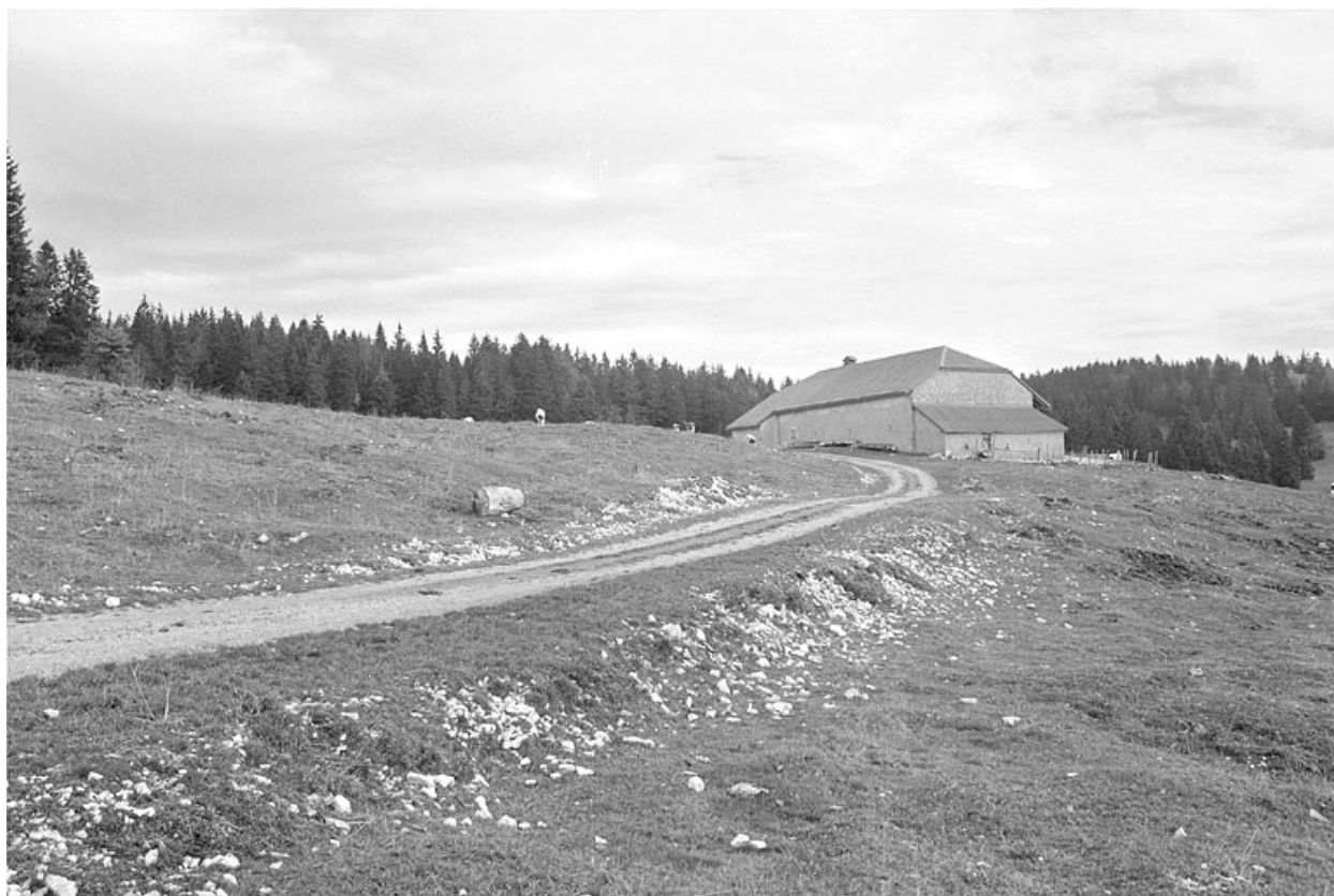
Vue générale depuis le chemin d'accès.
