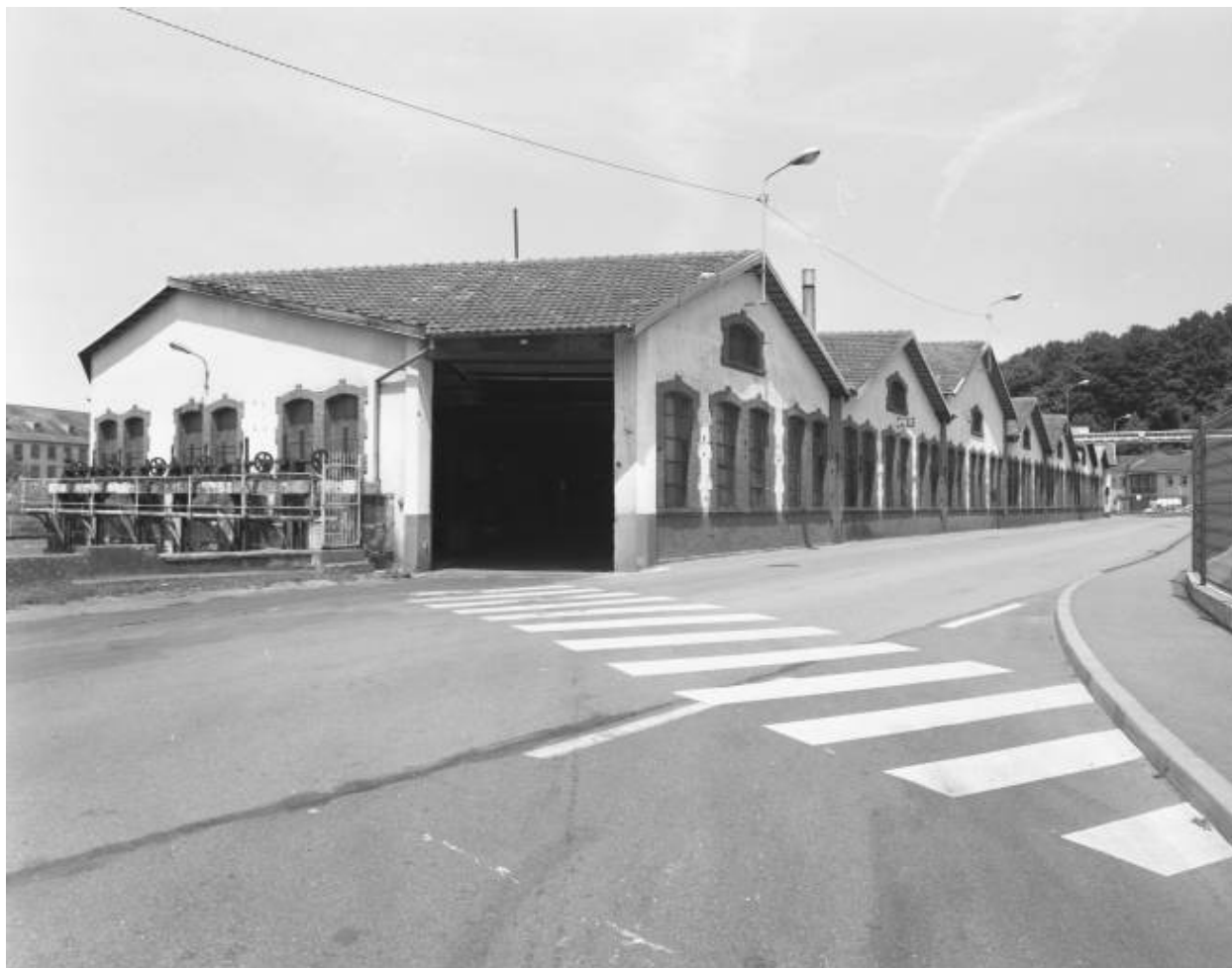
Ancienne fonderie vue de trois quarts gauche.
