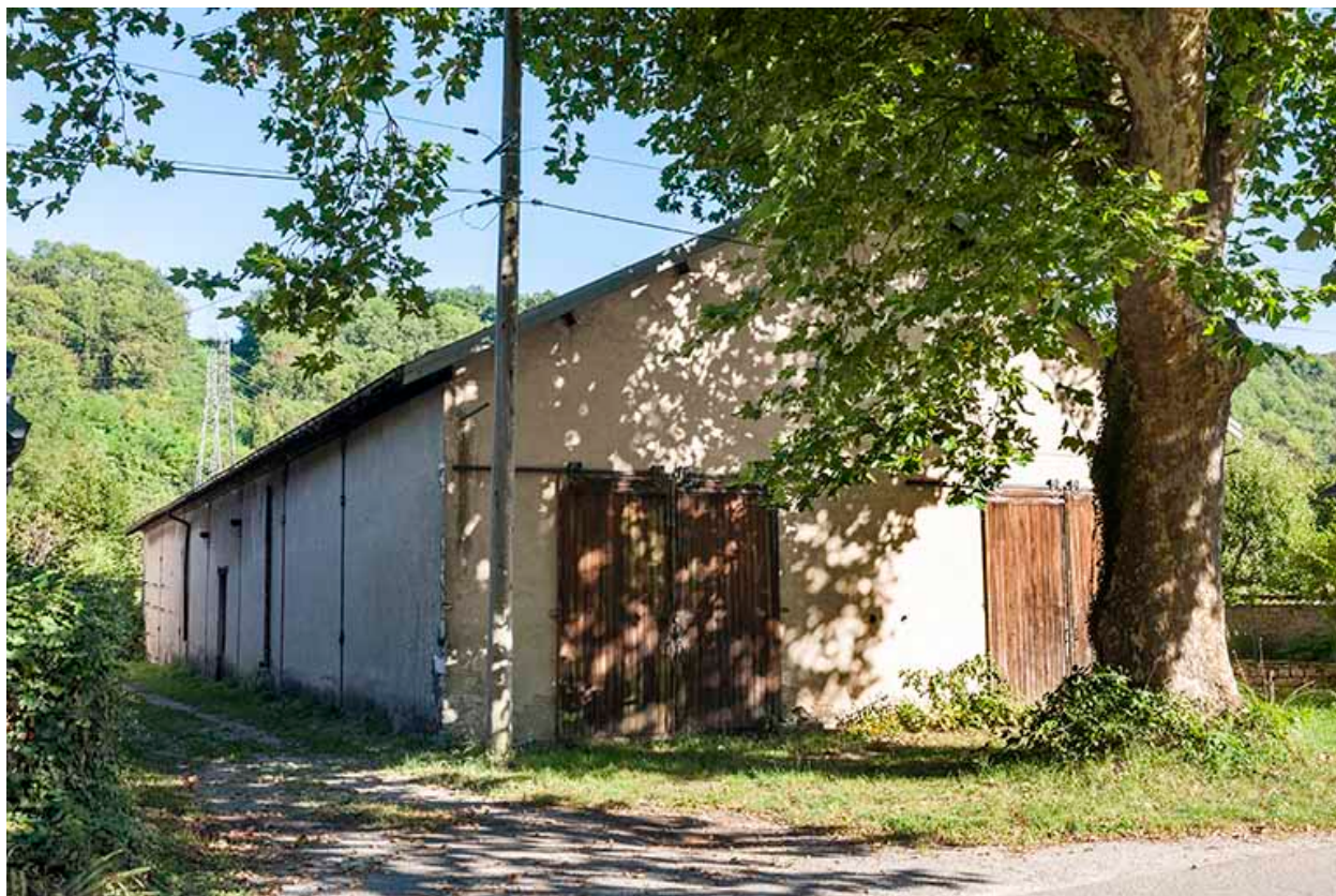
Magasin industriel vu depuis la route.
