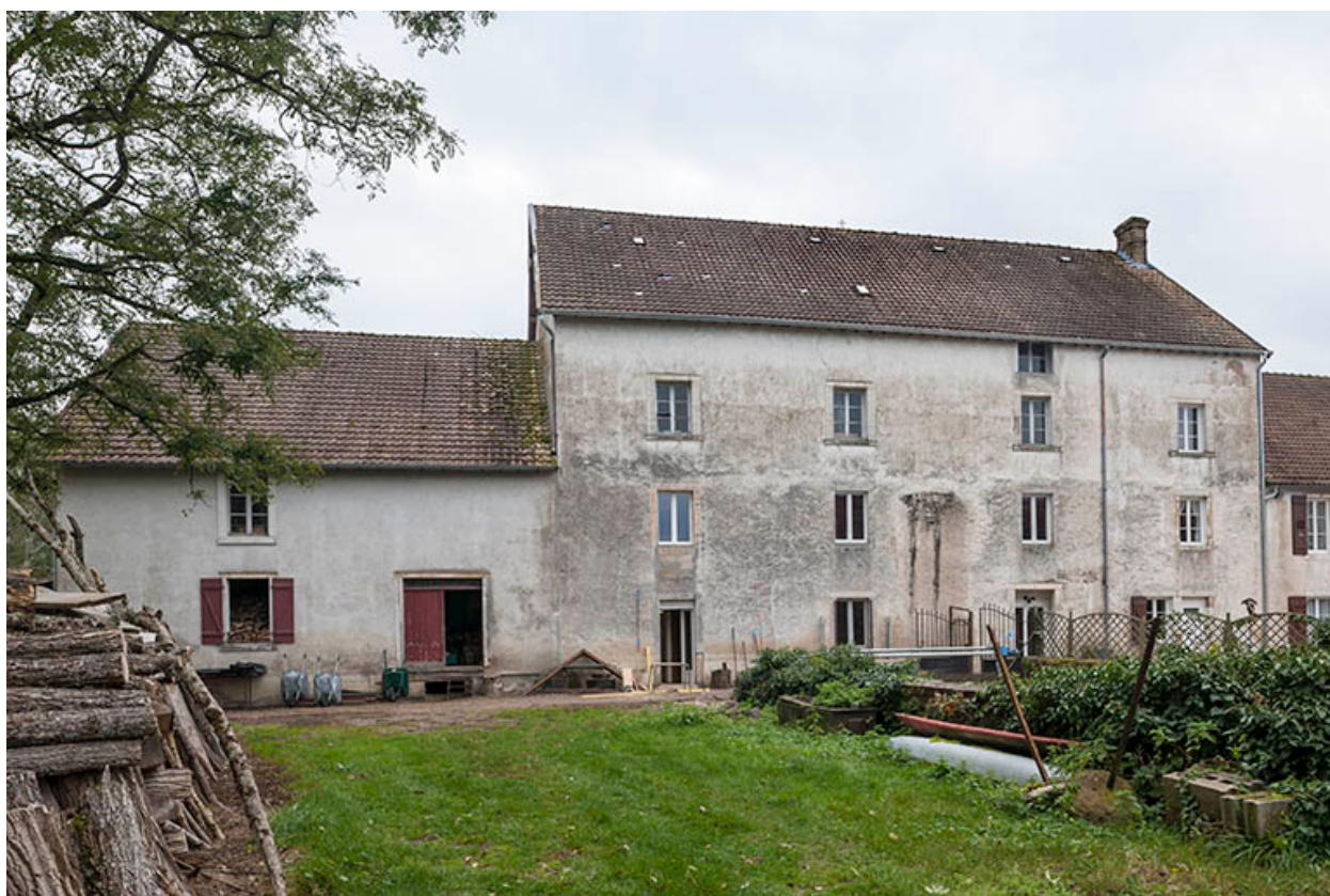
Façade ouest de l'atelier de minoterie.
