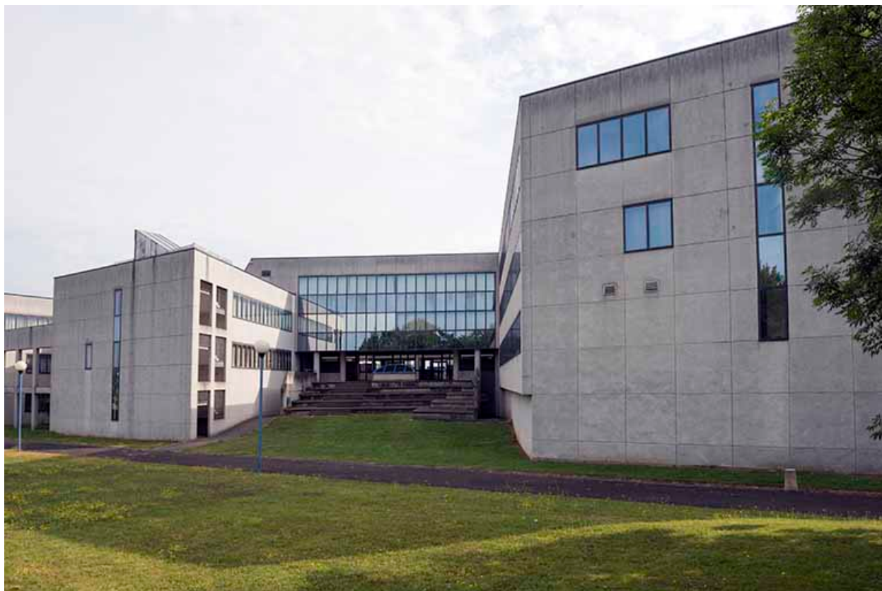
Détail d'un préau de la façade sud.
