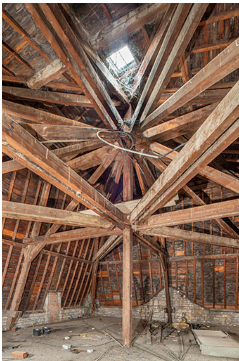
Charpente du pavillon ouest.
