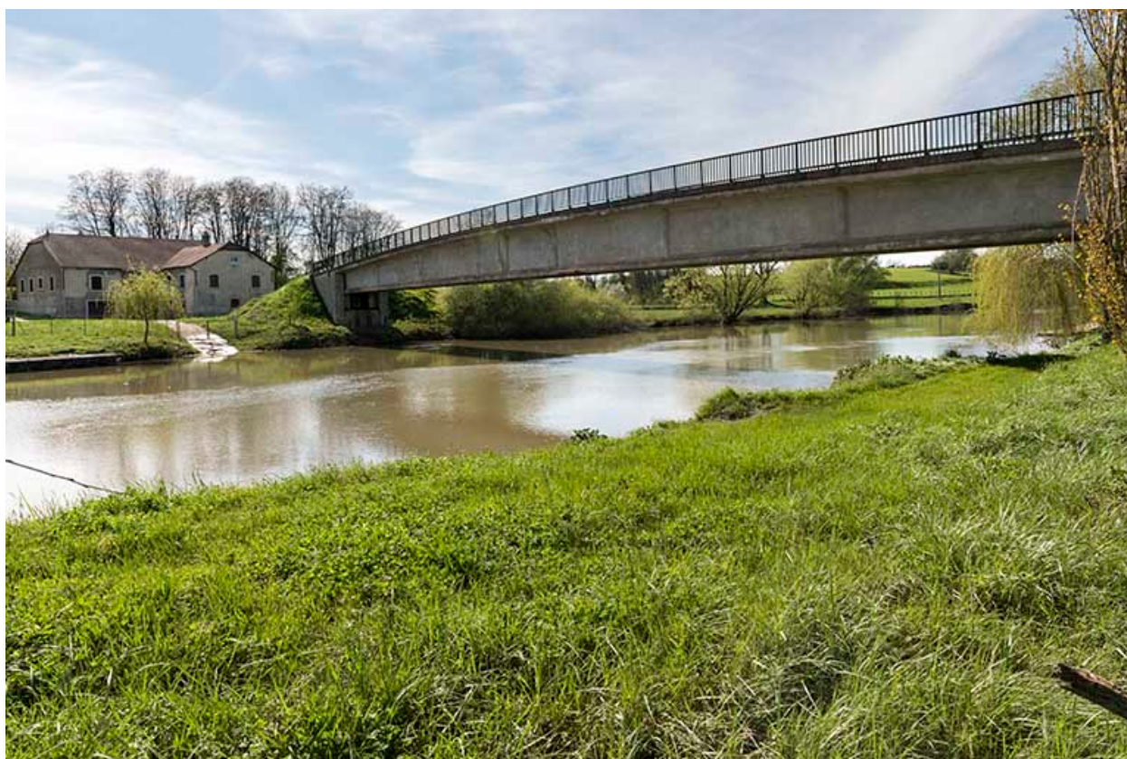
Franchissement de la Saône : pont de Fouchécourt.
