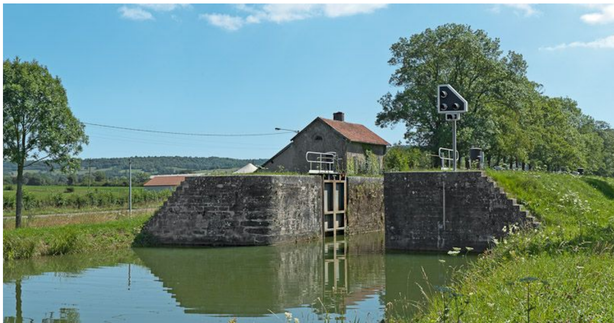
Vue du site d'écluse depuis l'aval.
