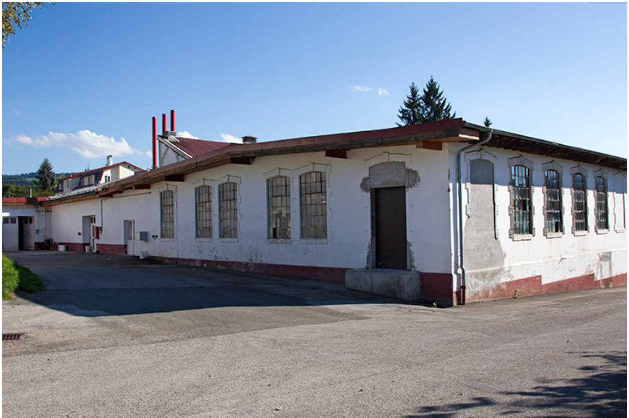
Bâtiments sud : façades postérieure et latérale droite.
