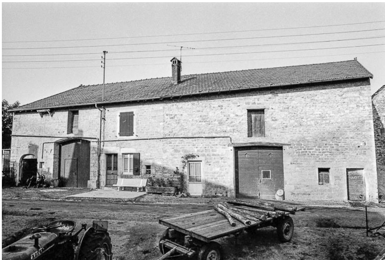
Ferme cadastrée A3 204 : façade antérieure.
