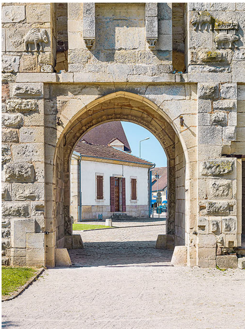
Le passage voûté de la porte.
