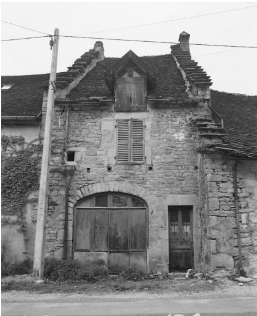
Façade antérieure de face.
