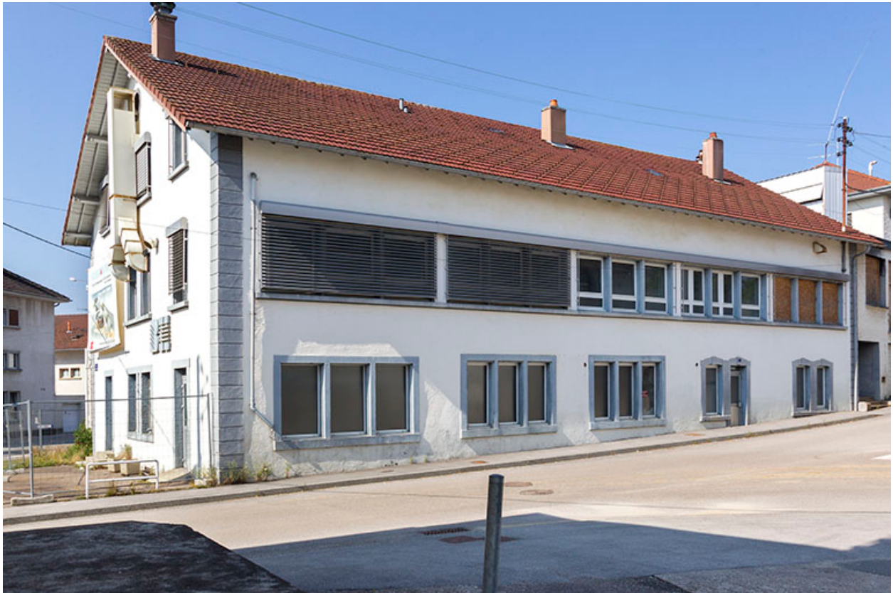
Usine, 1er corps de bâtiment : façade antérieure.
