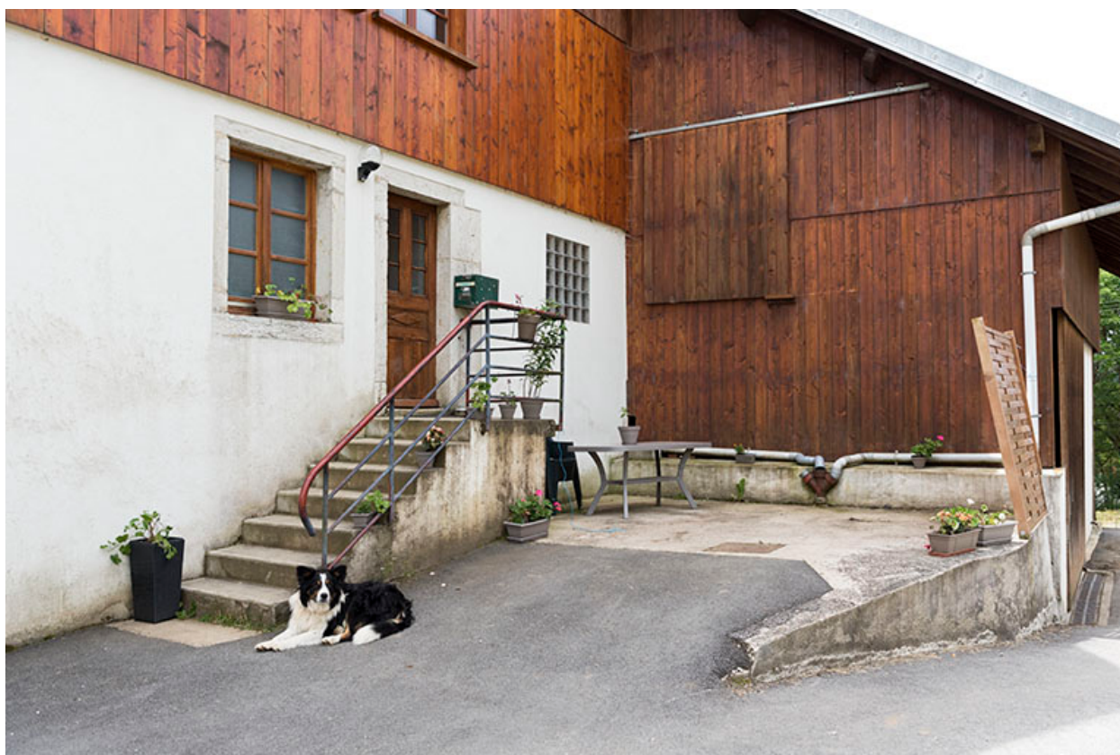
Façade latérale droite : escalier extérieur et étable.
