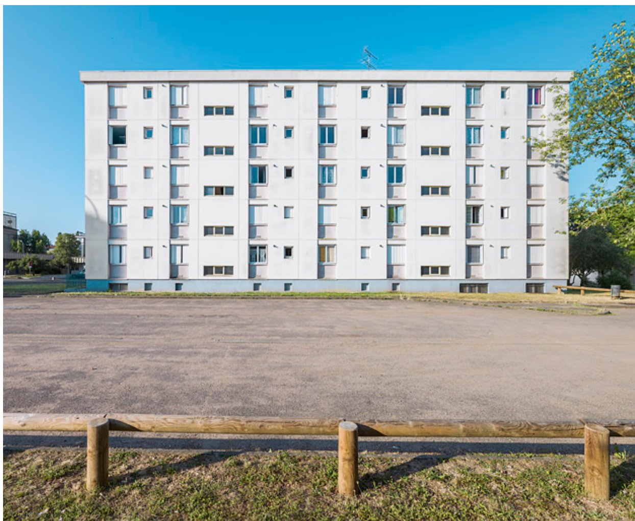
Bâtiment B-1, façade postérieure nord.
