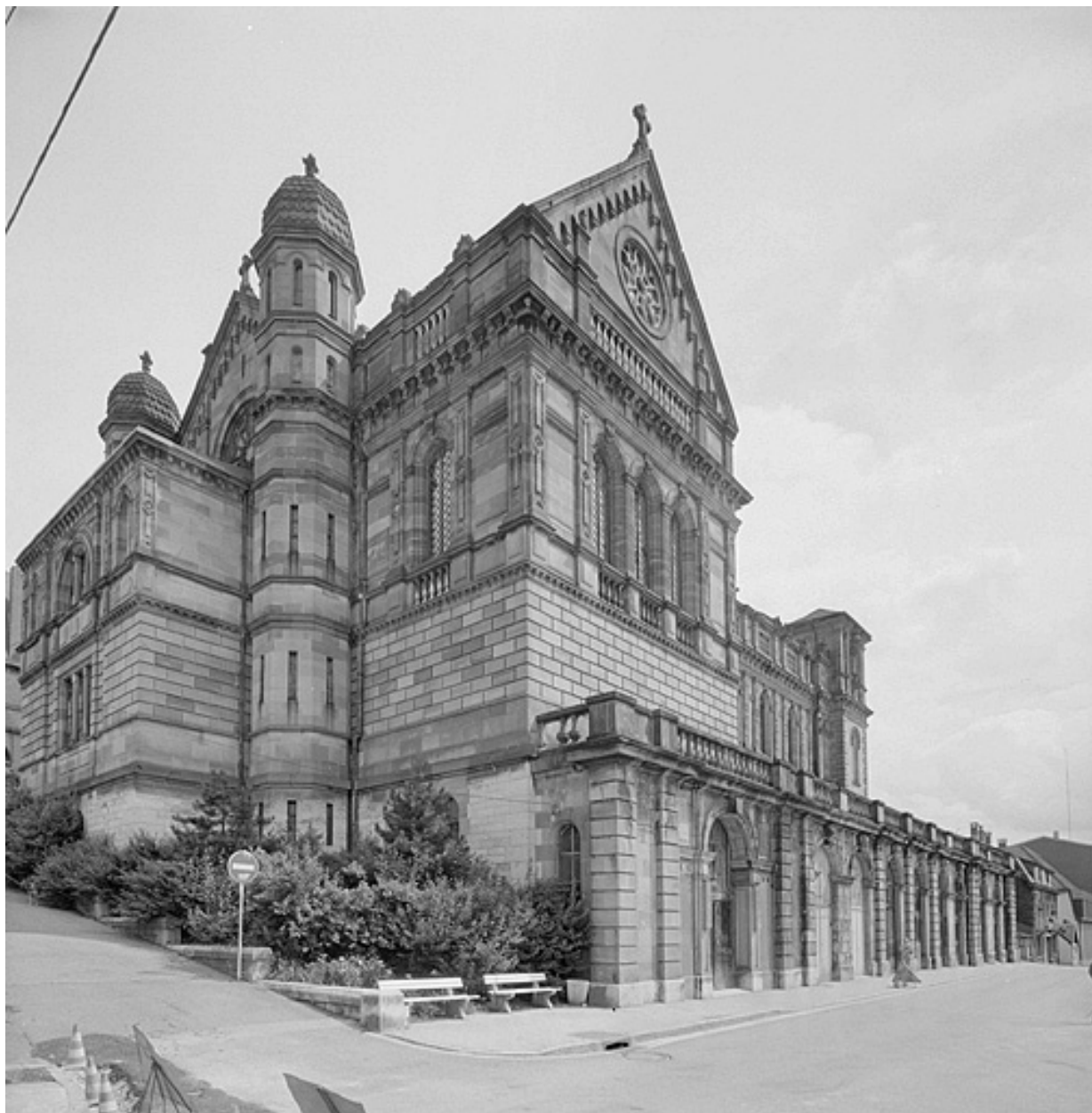
Vue d'ensemble du chevet et du transept.
