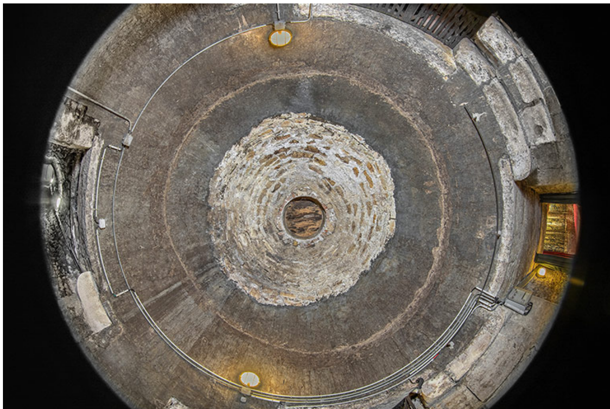
Plafond du niveau inférieur.
