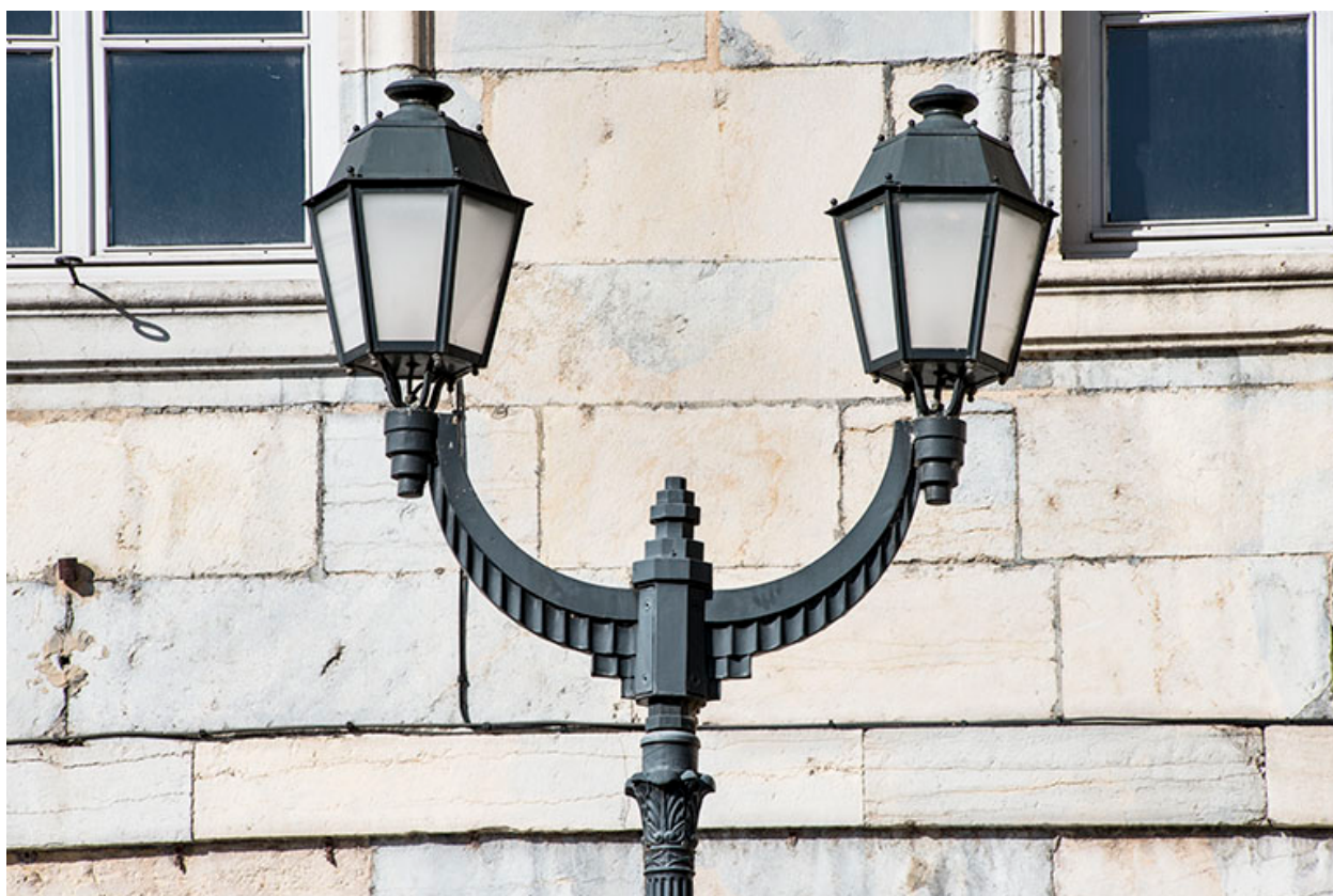
Façade antérieure : lampadaire proche du passage couvert.
