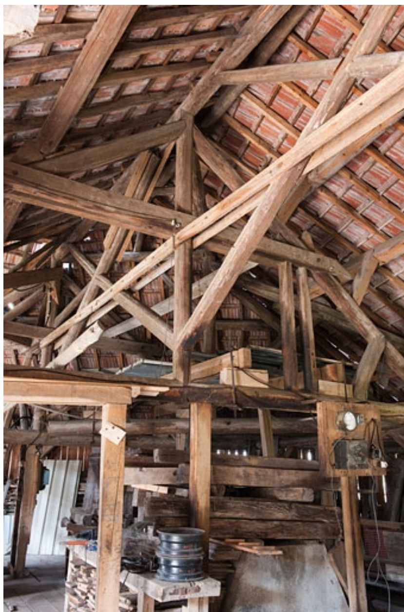
Scierie Courtot, rue du Pont : charpente.
