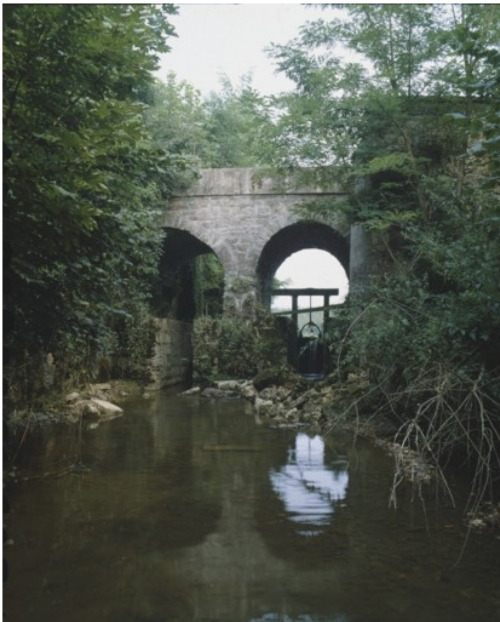
Canal de décharge en 1989.
