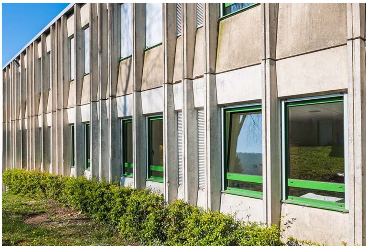
Façades préfabriquées : détail.
