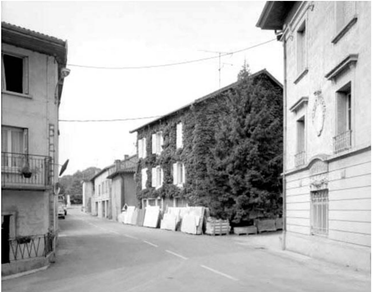
Logement patronal et logement d'ouvriers.
