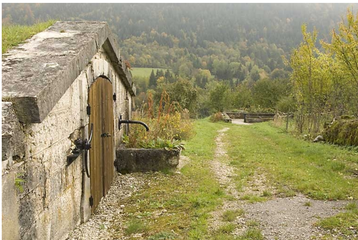
Réservoir des Maillots : façade vue en enfilade.
